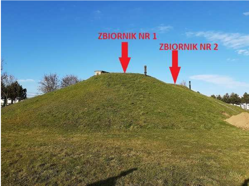
Fot. 1. Widok ogólny zbiorników.
