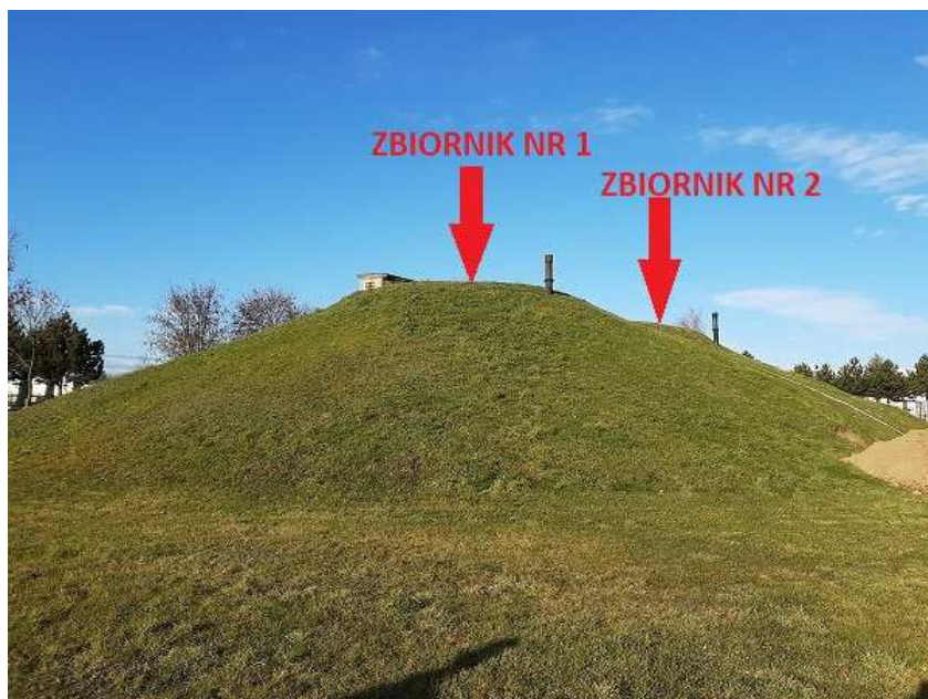
Fot. 1. Widok ogólny zbiorników.
