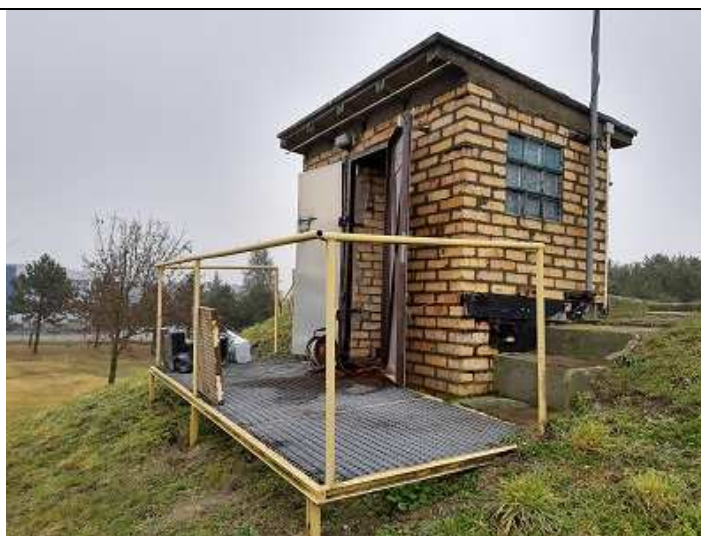
Fot. 14. Widok ogólny zabudowy wejścia do zbiornika – konstrukcja pomostu oraz część murowana wymagają kompleksowego remontu oraz częściowej wymiany.
