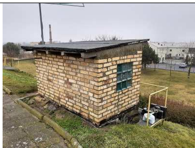
Fot. 16. Pokrycie dachu wymaga wymiany, obróbki blacharskie wymagają odtworzenia.
