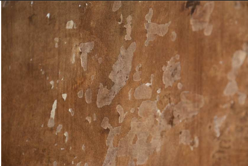
Fot. 8. Fragment ściany zbiornika, widoczne ubytki cienkiej, powierzchniowej warstwy powłoki zabezpieczającej.
