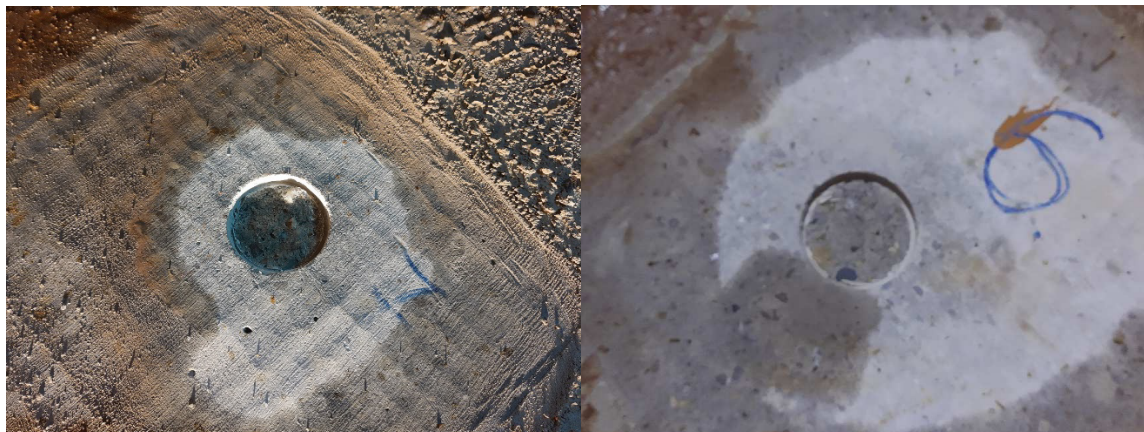
Fot. 20. Miejsca wykonania badania „pull-off” na powierzchni płyty dennej – prawidłowy przetóm widoczny w warstwie betonu na głębokości ok 1 cm.
