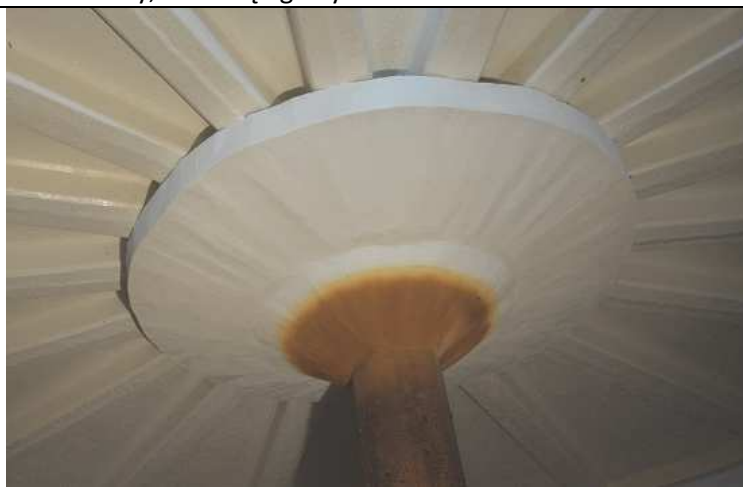
Fot. 6. Głowica słupa centralnego wraz z fragmentami żeber - pozorny brak widocznych uszkodzeń – uszkodzenia występują pod powłoką.
