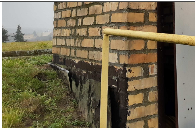
Fot. 15. Uszkodzenia opierzeń blacharskich oraz izolacji.
