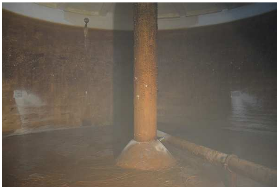
Fot. 2. Widok ogólny wnętrza zbiornika – zbiornik nr 2.
