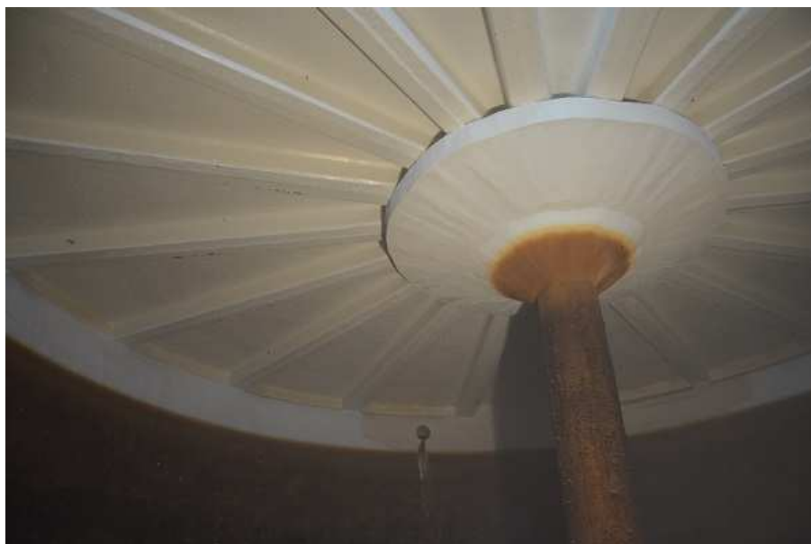
Fot. 3. Widok płyty stropowej i słupa centralnego – zbiornik nr 2
