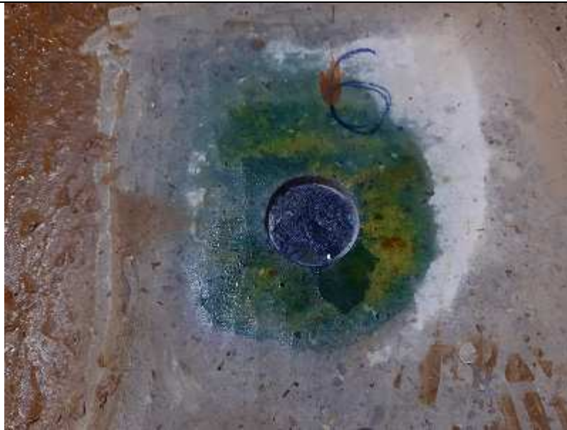
Fot. 21. Wynik Rainbow-Testu (kolor granatowy – \text{pH} > 11 ) w miejscu wykonania pomiaru „pull-off” (praktycznie brak karbonatyzacji) – warstwa betonu konstrukcyjnego, płyta denna.
