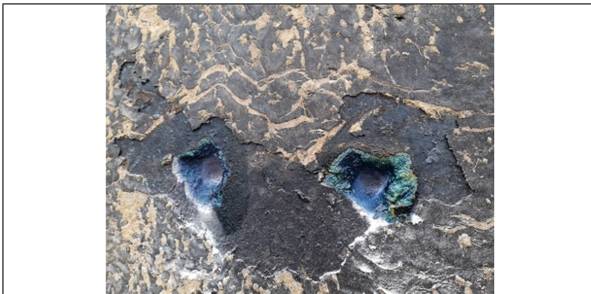
Fot. 23. Wynik Rainbow-Testu (kolor granatowy – \text{pH} > 11 ) (praktycznie brak karbonatyzacji) – warstwa betonu konstrukcyjnego od strony zewnętrznej, ściana.
