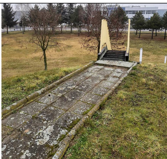
Fot. 17. Chodnik wykonany z płyt betonowych uszkodzony – wymagana przebudowa z zastosowaniem nowej nawierzchni – np. kostka betonowa.
