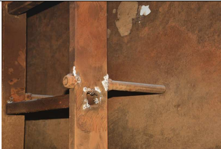
Fot. 11. Skorodowane elementy stalowe – korozja śrub mocujących drabinę.
