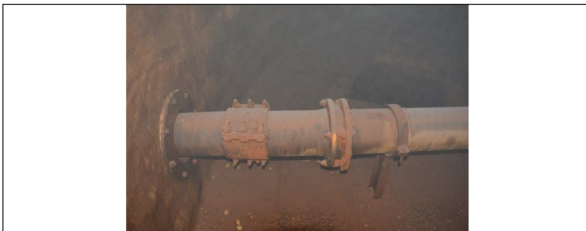
Fot. 4. Widok fragmentu rurociągu wraz z przejściem przez ścianę zbiornika – widoczna skorodowana obejma oraz kołnierz, rury PE w dobrym stanie technicznym.
