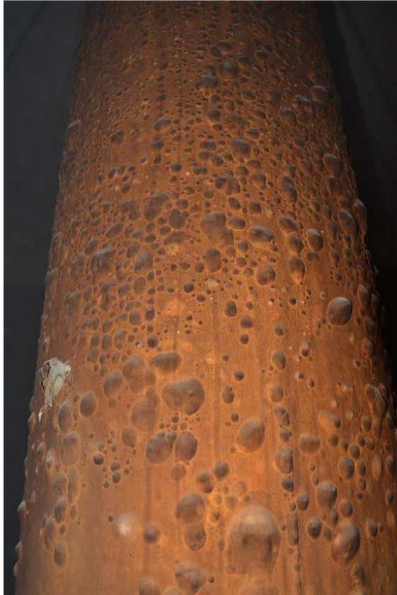
Fot. 10. Słup – uszkodzona powłoka naprawcza – żywica epoksydowa
