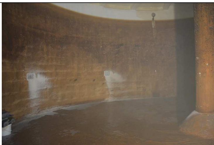
Fot. 7. Fragment ściany zbiornika oraz słup centralny.
