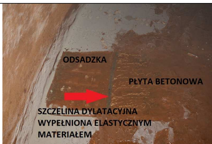
Fot. 13. Połączenie płyty dennej oraz ściany.
