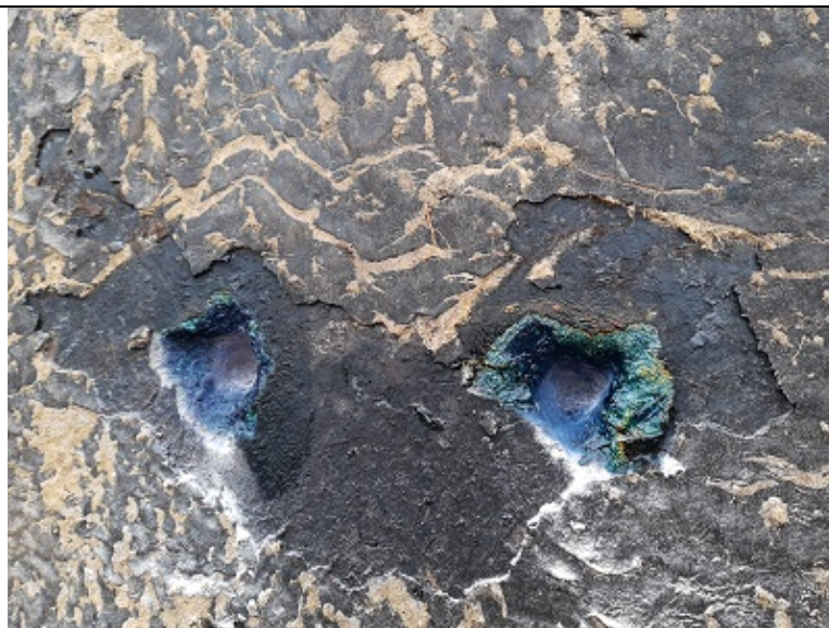
Fot. 19. Odkrywki punktowe od zewnętrznej strony obiektu – brak uszkodzeń.
