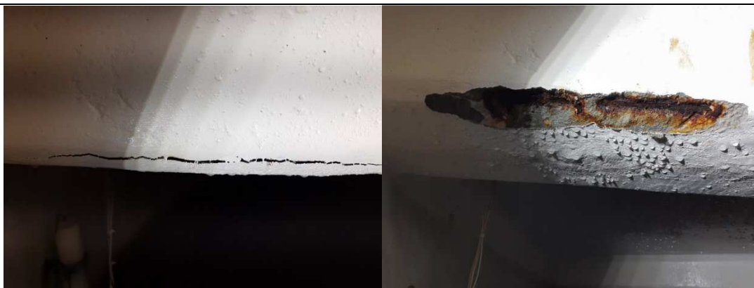
Fot. 5. Widok żebra płyty stropowej – uszkodzenia otuliny, korozja zbrojenia, widoczne skropliny wody, które są agresywne w stosunku do betonu.
