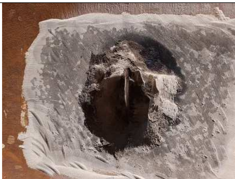
Fot. 18. Odkrywka punktowa – warstwa torkretu oraz zbrojenie prętami \phi 6\text{mm}
