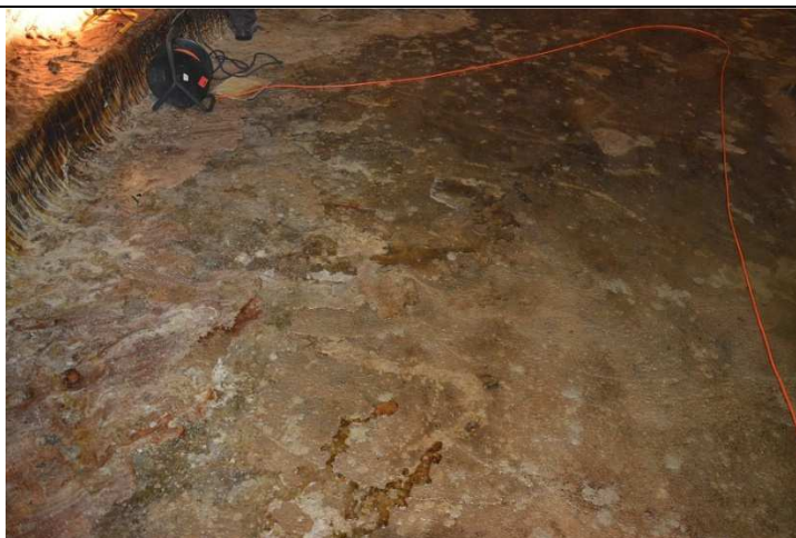
Fot. 12. Liczne zacieki z żywicy zastosowanej do zabezpieczenia ścian zbiornika.
