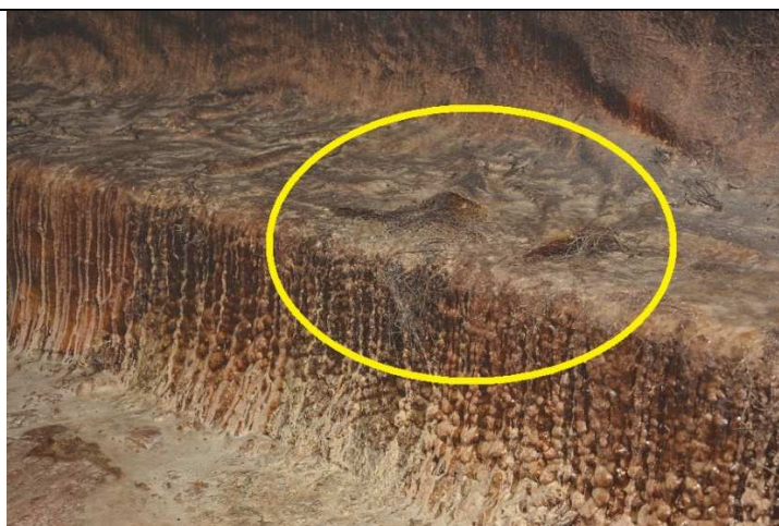
Fot. 13. Pęknięcia i odspojenia maty z włókna szklanego. Liczne sfałdowania oraz uszkodzenia struktury wykładziny.
