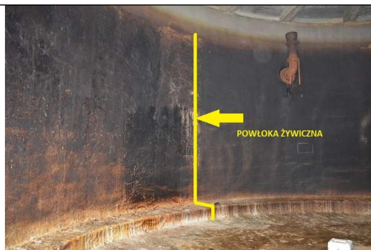
Fot. 7. Fragment ściany zbiornika – powłoka żywiczna.
