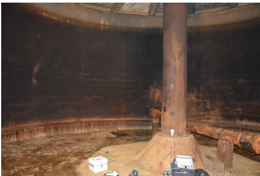
Fot. 2. Widok ogólny wnętrza zbiornika – zbiornik nr 1.
