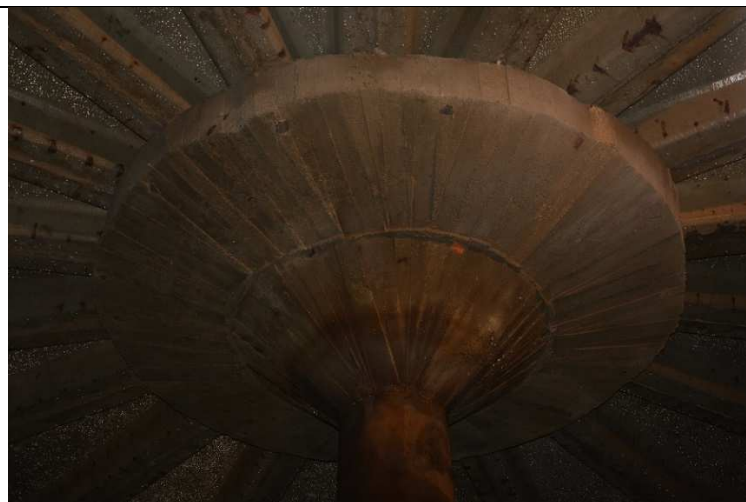
Fot. 6. Głowica słupa centralnego wraz z fragmentami żeber - widoczne ogniska korozji zbrojenia oraz miejscowe ubytki otuliny betonowej.
