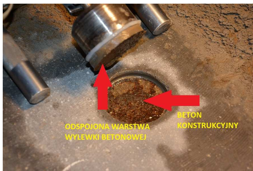
Fot. 20. Badanie „pull-off” na powierzchni stopy słupa – widoczne odspojenie warstwy wylewki betonowej – wylewka do usunięcia.
