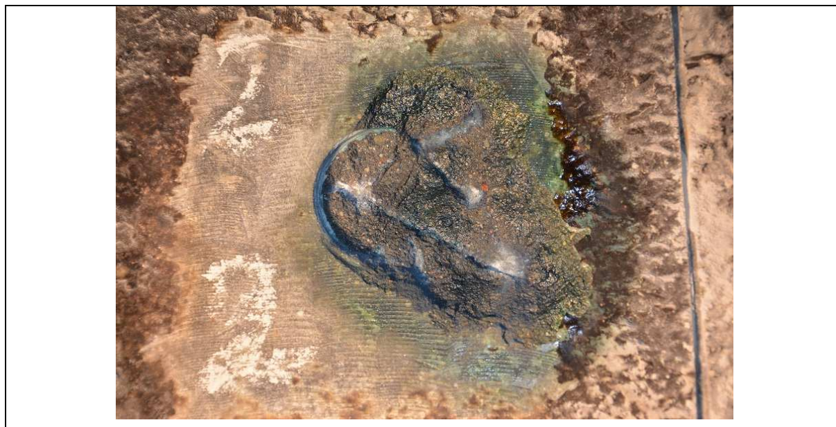
Fot. 21. Wynik Rainbow-Testu (kolor granatowy – \text{pH} > 11 ) w miejscu wykonania pomiaru „pull-off” (praktycznie brak karbonatyzacji) – warstwa torkretu
