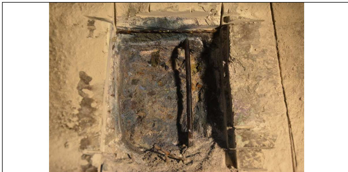
Fot. 22. Wynik Rainbow-Testu (kolor granatowy – \text{pH} > 11 ) (praktycznie brak karbonatyzacji) – warstwa betonu konstrukcyjnego.
