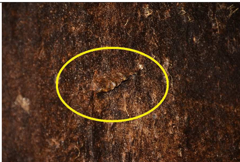
Fot. 9. Widok fragmentu wykładziny z maty żywicznej – nieprawidłowy montaż, pofałdowania.
