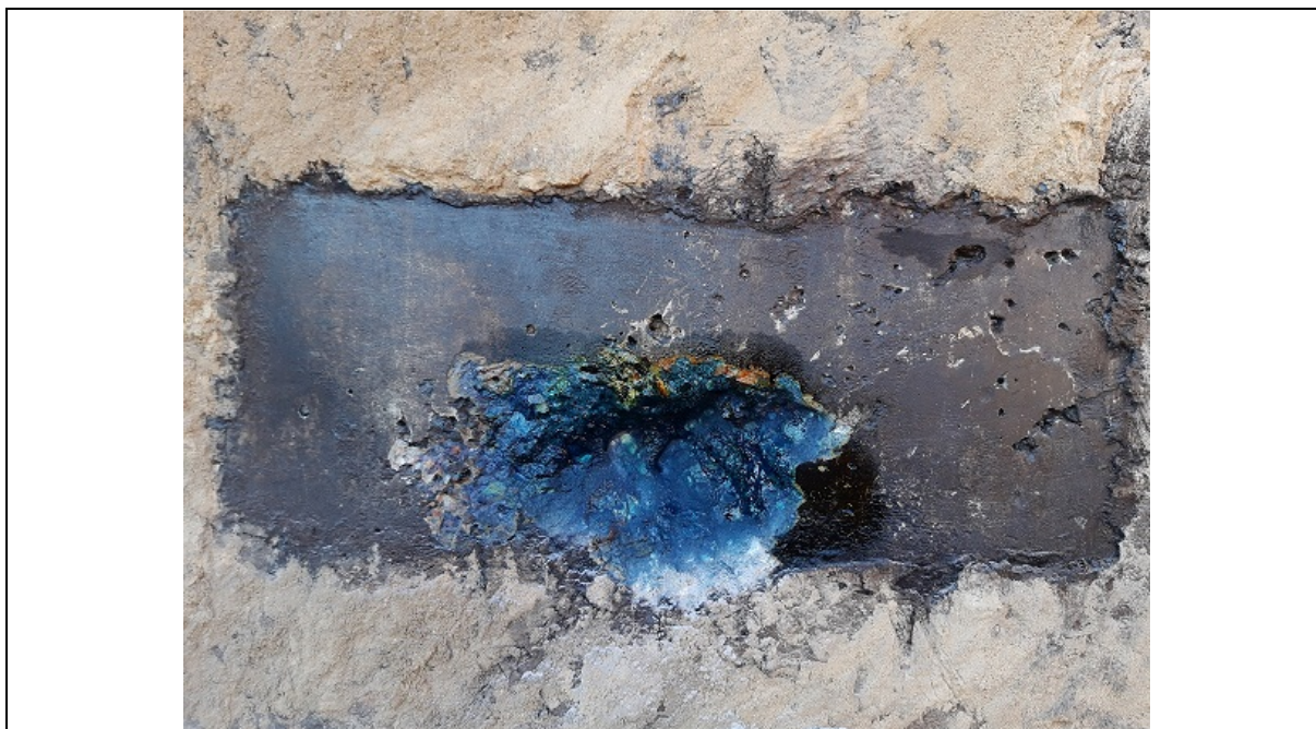
Fot. 23. Wynik Rainbow-Testu (kolor granatowy – \text{pH} > 11 ) (praktycznie brak karbonatyzacji) – warstwa betonu konstrukcyjnego od strony zewnętrznej.
