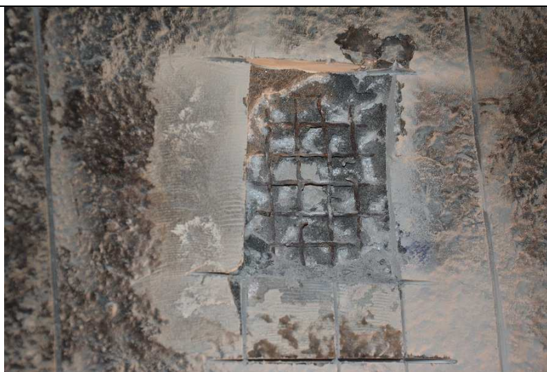
Fot. 18. Odkrywka punktowa – warstwa torkretu oraz zbrojenie w postaci siatki z prętów \phi 2,6\text{mm} w rozstawie 20 x 20 mm.
