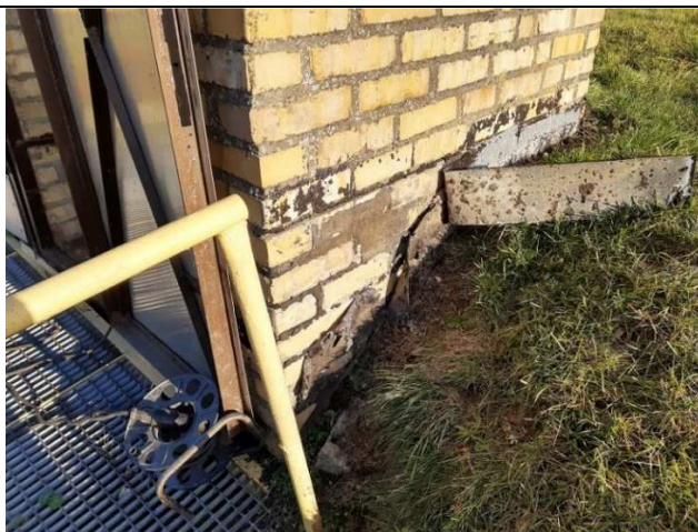
Fot. 15. Uszkodzenia opierzeń blacharskich oraz izolacji.
