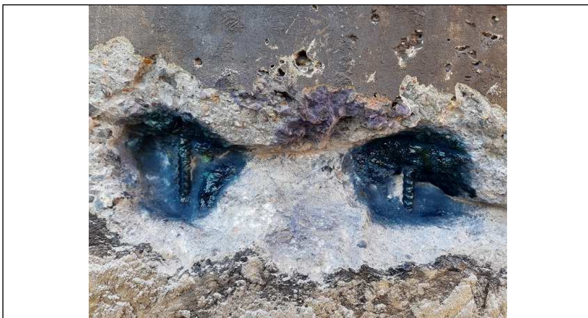
Fot. 24. Wynik Rainbow-Testu (kolor granatowy – \text{pH} > 11 ) (praktycznie brak karbonatyzacji) – warstwa betonu konstrukcyjnego od strony zewnętrznej.
