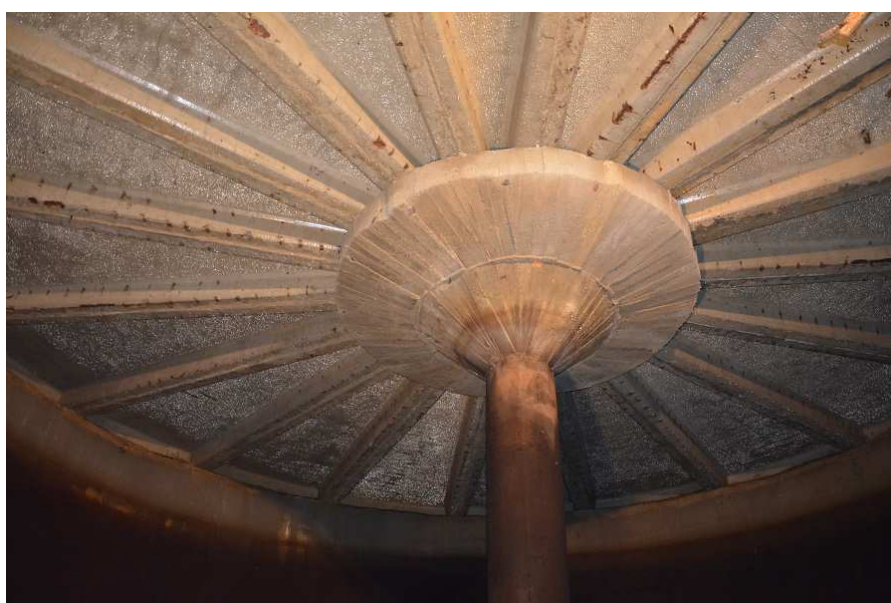
Fot. 3. Widok płyty stropowej i słupa centralnego – zbiornik nr 1.
