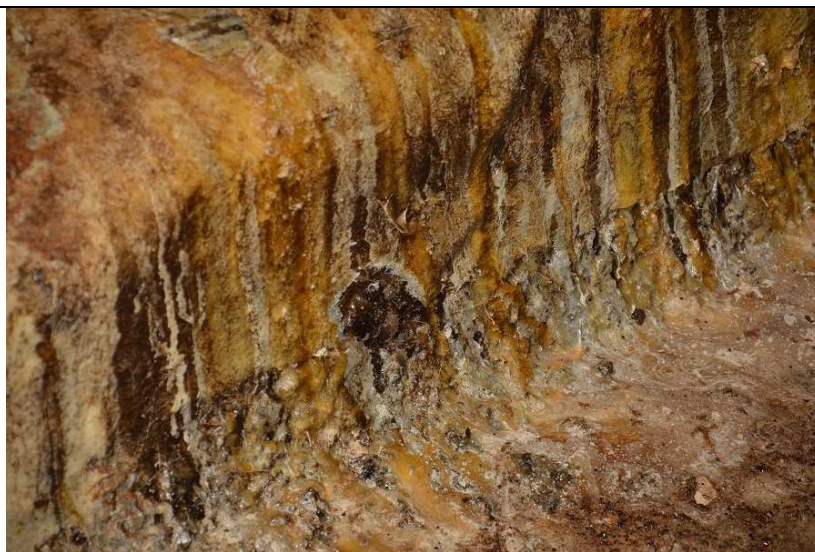
Fot. 8. Odsadzka ławy fundamentowej – nieprawidłowo ułożona mata z włókna szklanego, liczne zacieki żywicy, brak odpowiedniego wykończenia warstw żywicznych i połączenia ich z betonem.
