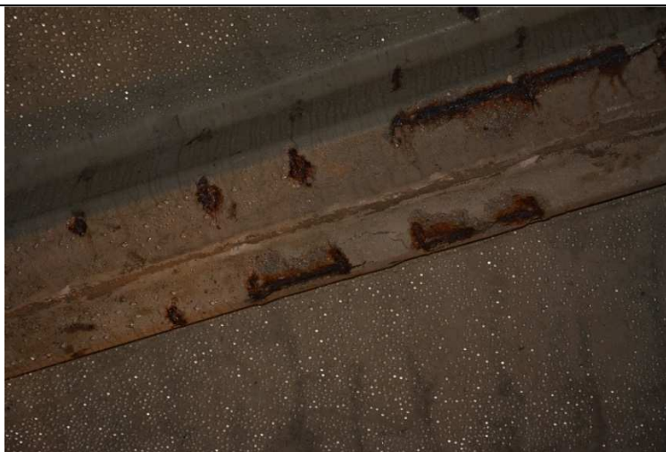
Fot. 5. Widok żebra płyty stropowej – uszkodzenia otuliny, korozja zbrojenia.
