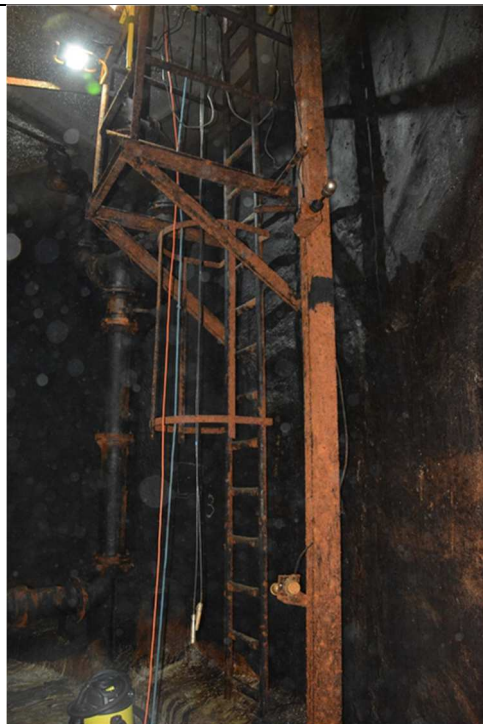
Fot. 11. Skorodowane elementy stalowe.
