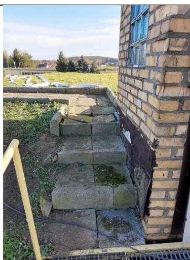
Fot. 17. Chodnik wykonany z płyt betonowych uszkodzony – wymagana przebudowa z zastosowaniem nowej nawierzchni – np. kostka betonowa.
